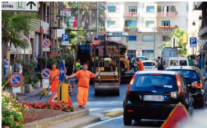
Una giornata di code e disagi in centro città per il cantiere stradale di via Brignoni
